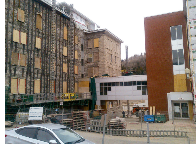
L'entrepreneur Martin Tremblay et son équipe chez Qualité Construction ont construit le nouvel hôtel de ville de Baie-Saint-Paul.
